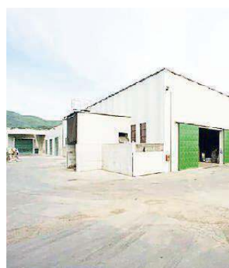
Uno dei capannoni della Costa
